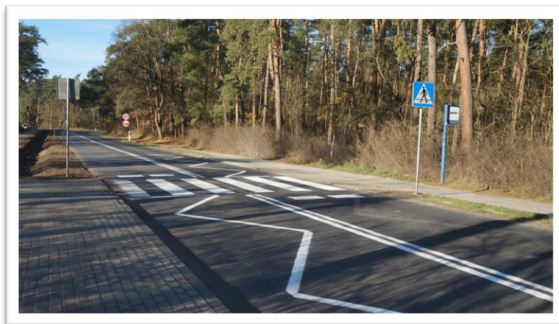
Fotografia 13. Wykonanie przejścia dla pieszych i chodnika w miejscowości Wieniec Zalesie.
